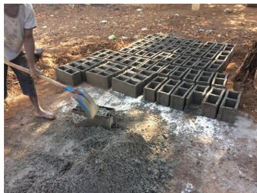
Fabrication sur place des ferrailles et des parpaings, qui servent à réaliser les fondations creusées à la pèle...
