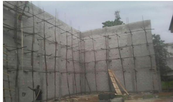
Les 3 murs sont maintenant érigés avec deux piliers de renforcements derrière le frontis et le mur arrière pour assurer une totale sécurité.
